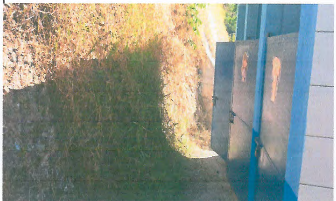
Foto 4: MURO DE CONTENSIÓN FRENTE A SANITARIOS
